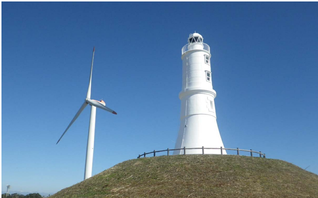
静岡県磐田市 掛塚灯台
